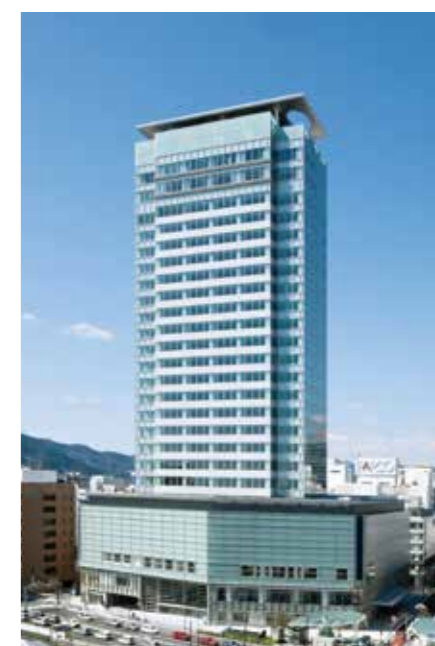
葵タワー(静岡市)
