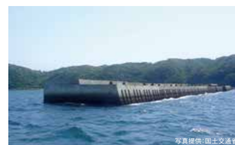
下田港防波堤(下田市)
